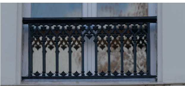
▶ Garde-corps en fonte dans l'embrasure
