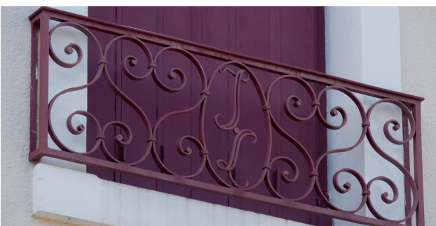
▶ Garde-corps en applique avec initiales incrustées
