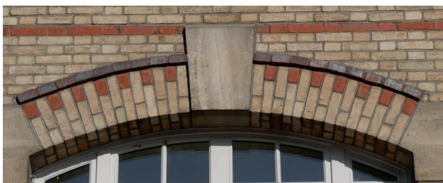
▶ Décors en briques et en pierres de taille
